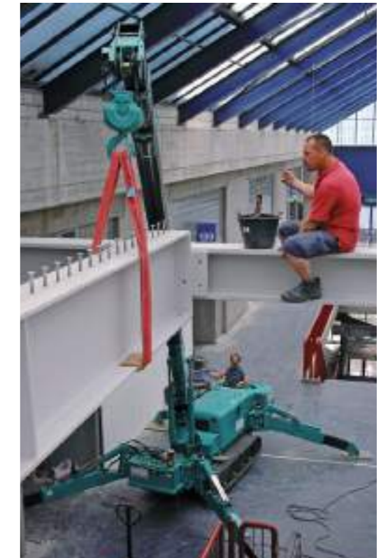
MC305C Stahlbau Bea Halle Messe Bern
